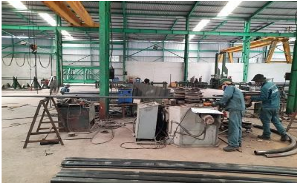
Hình 1.1.3:dự án “GIA CÔNG CHẾ TẠO LAN CAN TUYẾN ĐƯỜNG VÀNH ĐAI, NÚT GIAO THÔNG NGỌC HỘI,TỈNH KHÁNH HÒA”
